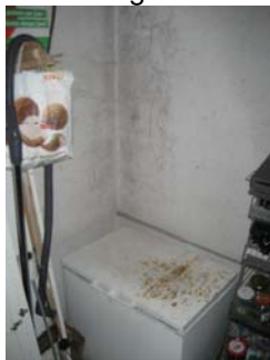
Keller Wand über Kühltruhe
