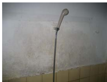
Wand oberhalb BW
