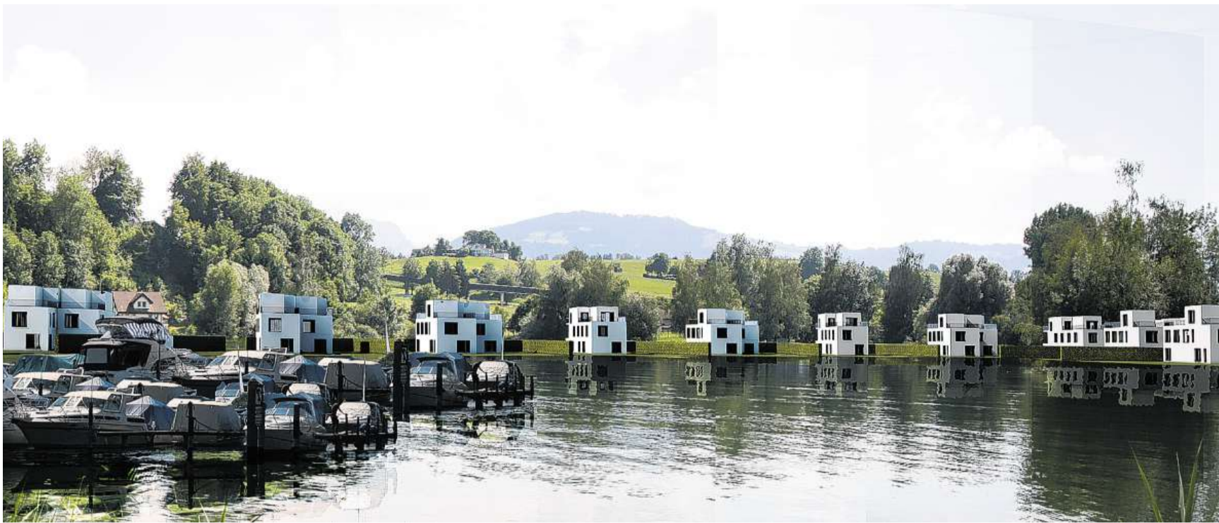
Über das Bauprojekt «Nuolen See» entscheidet vermutlich das Bundesgericht. Das Verwaltungsgericht Schwyz sagte schon mal nein dazu.
